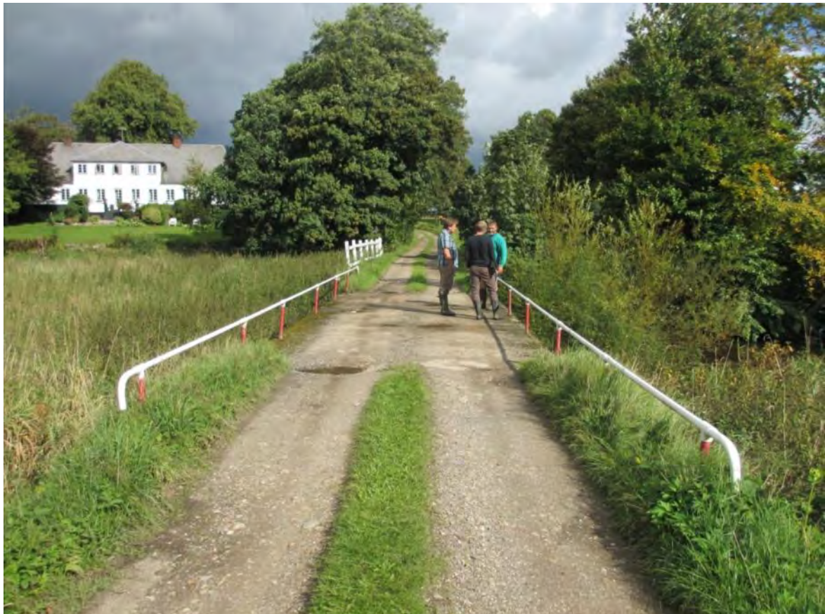
Figur 11 Adgangsvej fra Esbjergvej, som krydser Holsted Å
